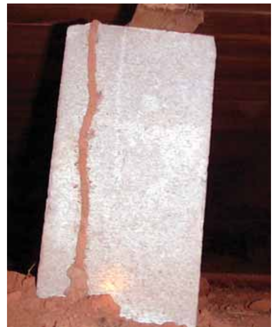
Fig. 2. Las termitas construyen túneles para protegerse contra los efectos desecantes del aire y para protegerse contra los enemigos naturales, como las hormigas.
